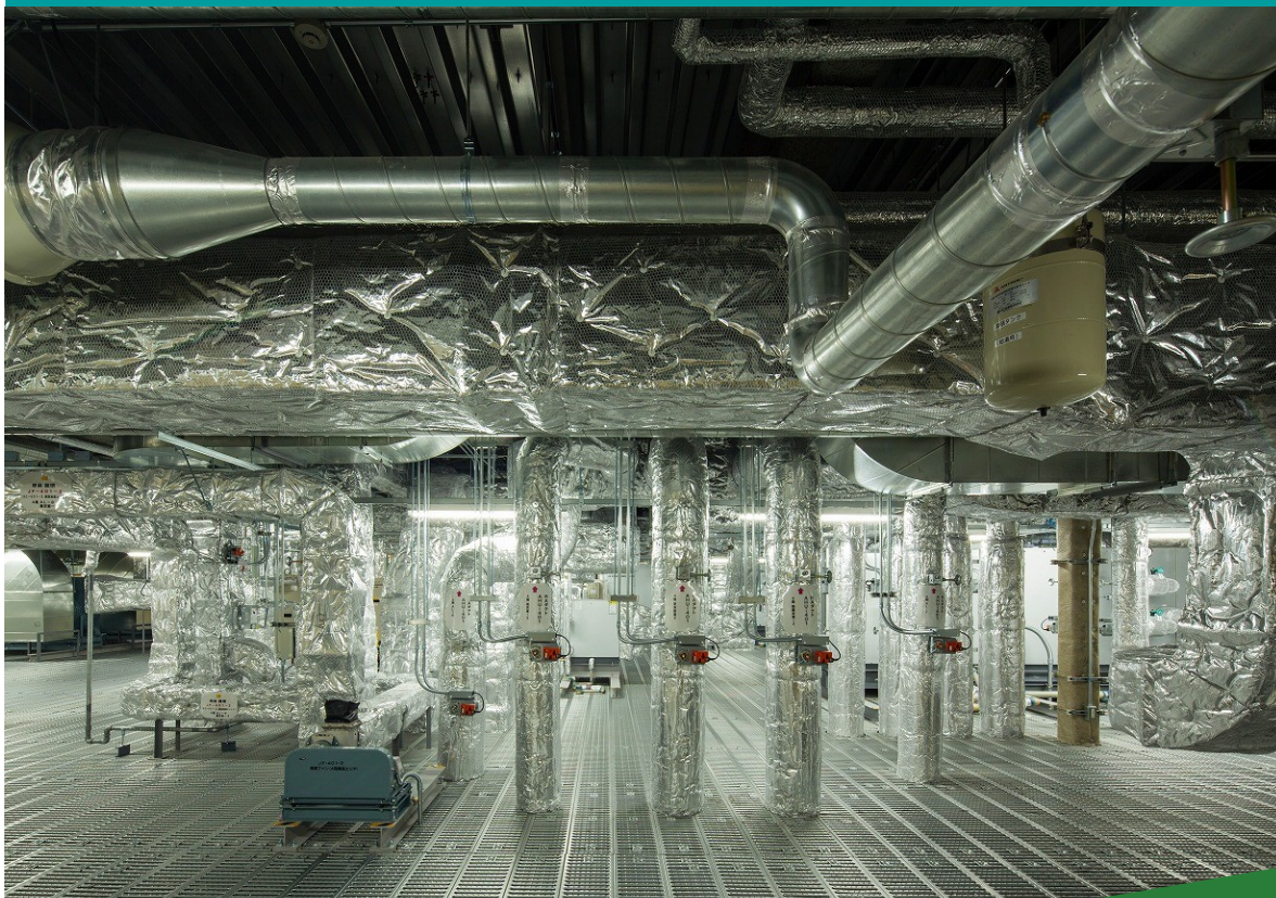
ダクト類が巡らされた設備フロアはT-CUBEの心臓部
